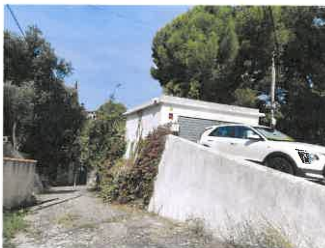
Garage situé en bordure de route
