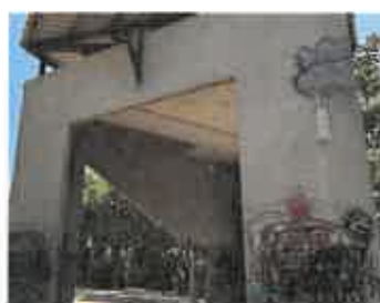
Etat des voiles en béton armé
