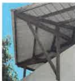
Charpente bois fixée sur la structure
