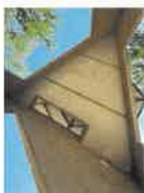
Dalle béton armé
