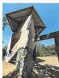
Vue globale de la structure
