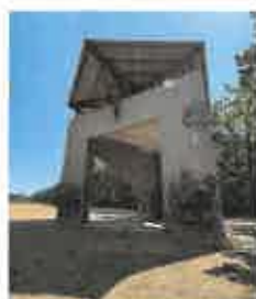
Vue globale de la structure
