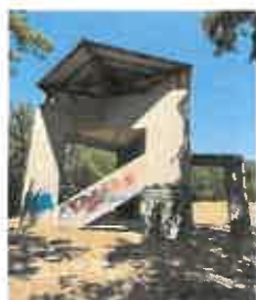
Vue globale de la structure
