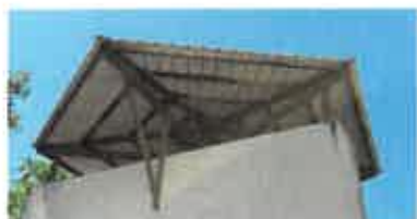
Charpente bois fixée sur la structure
