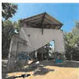
Vue globale de la structure
