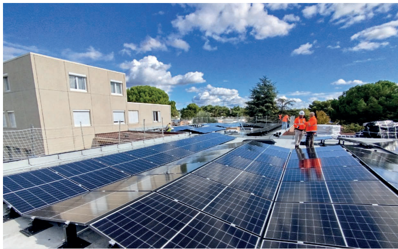
Installation de panneaux photovoltaïques sur le groupe scolaire Plan de la Cour
