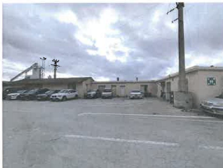
Bâtiment à usage de salle de repos, vestiaire et stockage
