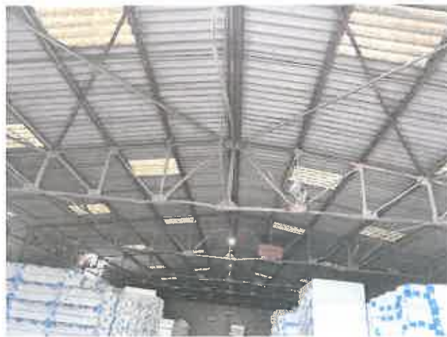
Hangar principal (toiture et charpente en mauvais état)
