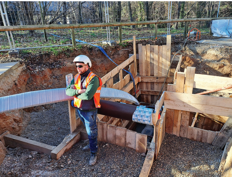
Insertion d'une gaine en Kevlar dans la canalisation
