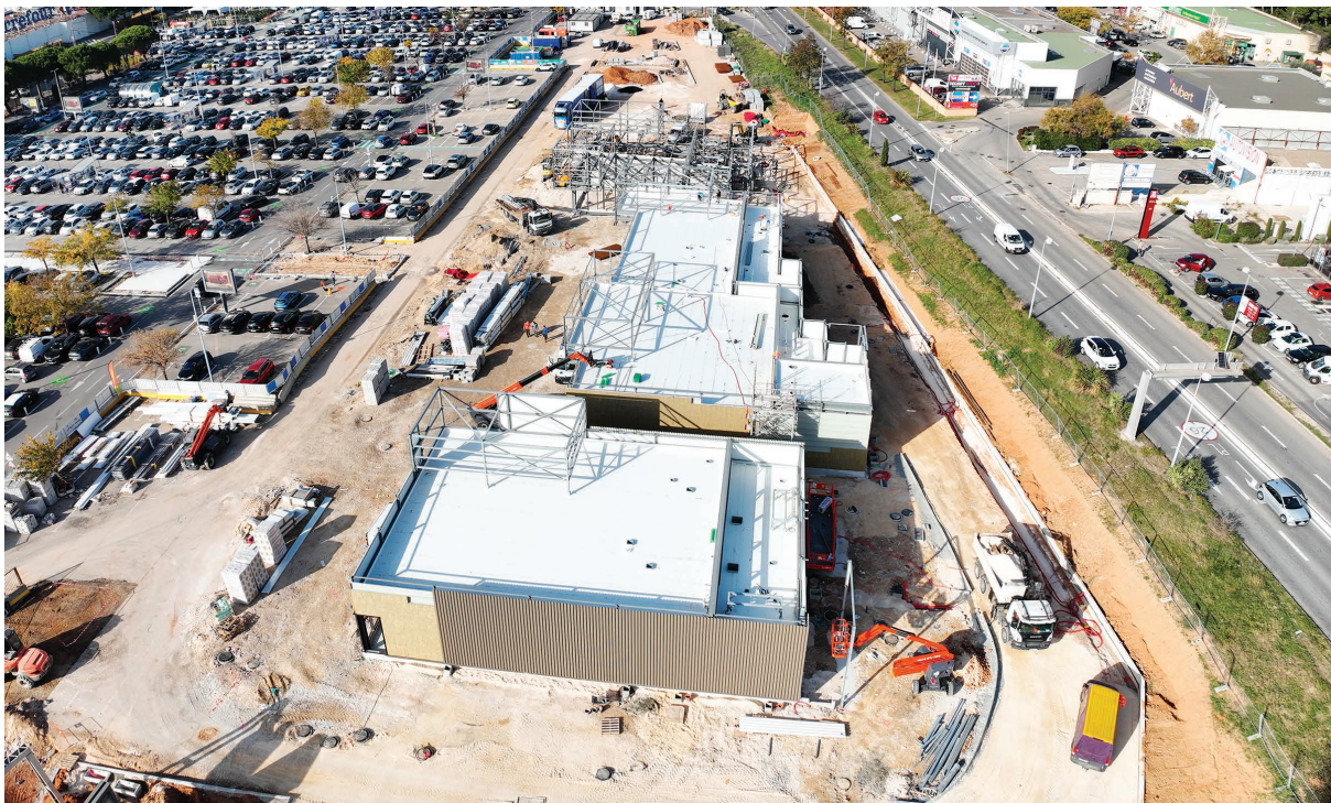
Construction des bâtiments pour l'accueil de cinq nouvelles enseignes de restauration sur le parking de Carrefour.
