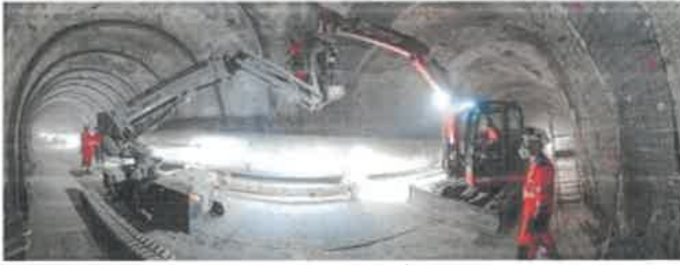
Pose des treillis pour soutènements
