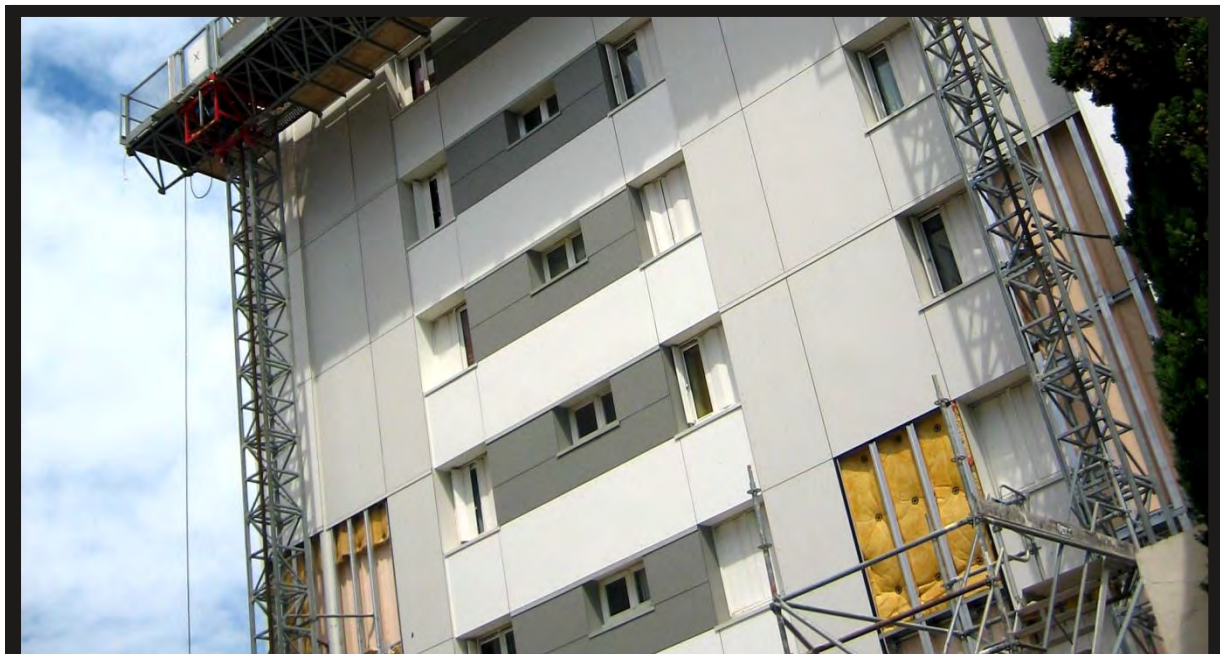
Rénovation thermique dans le quartier des Pins
