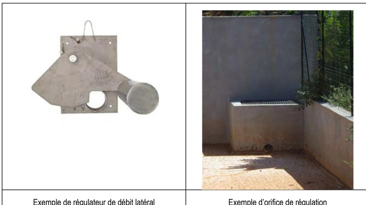
En l'absence de régulateur de débit, le débit de fuite contrôlé par un orifice ne pourra être inférieur à 5 l/s et le diamètre minimal de l'orifice ne devra pas être inférieur à 50 mm pour éviter les risques liés au colmatage.
