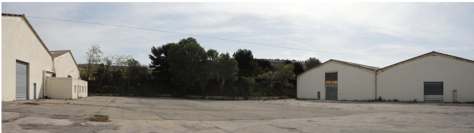
Place centrale entre les hangars à l'Ouest du secteur
