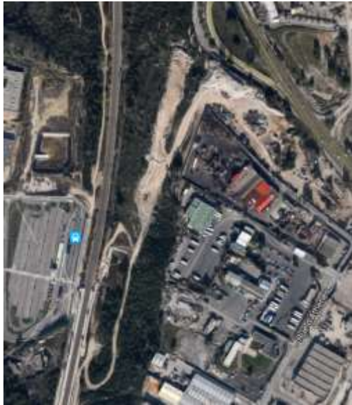
Vue aérienne de la zone N reclassée en 1AUch
