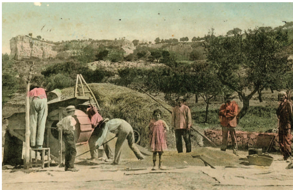
>>> Vannage du blé, avec un tarare, quartier du Castellàs
